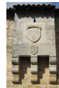
Mâchicoulis à bretèche au-dessus du logis abbatial.
