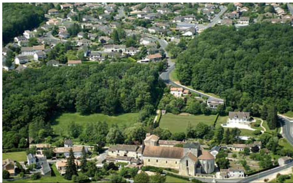
Vue aérienne de Fontaine-le-Comte.
